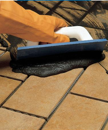
Verfugung von Spaltplatten mit Keracolor GG + Fugolastic im Außenbereich
