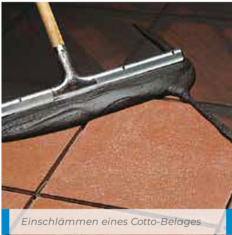
Einfugen eines Keramikbelages mit einer Gummifugscheibe
