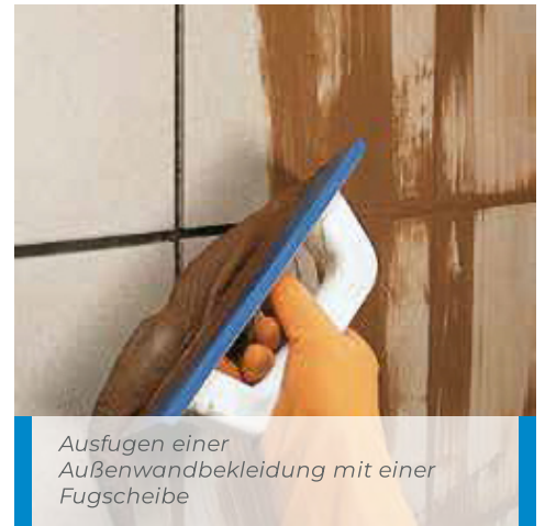
Einfugen eines Keramikbelages mit einer Gummifugscheibe
